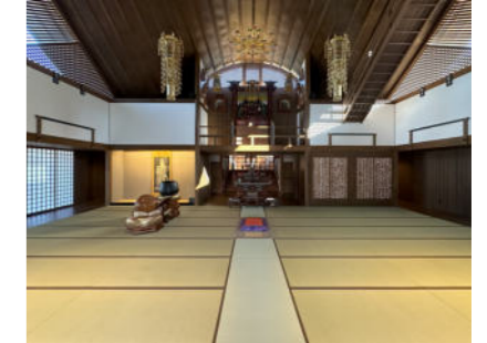
唐破風の垂木間に3次曲面の天井板が貼られる。龍骨は現場でさらに2間伸ばして15.4mになった。妻壁は格子組のガラス開口とし、朝夕は光が差し込む。
