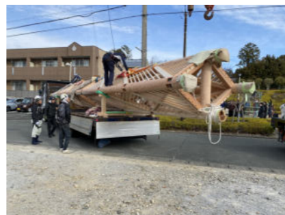
長さ12mの龍骨を大型トレーラーで搬入。クレーンで吊り上げて棟持柱の上に設置した。龍骨上げは檀家や近隣住民など多くの見物者が訪れた※4
