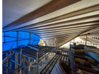
唐破風の垂木間に3次曲面の天井板が貼られる。龍骨は現場でさらに2間伸ばして15.4mになった。妻壁は格子組のガラス開口とし、朝夕は光が差し込む。
