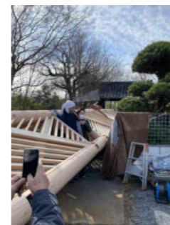
長さ12mの龍骨を大型トレーラーで搬入。クレーンで吊り上げて棟持柱の上に設置した。龍骨上げは檀家や近隣住民など多くの見物者が訪れた※4
