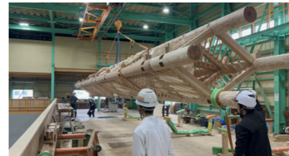
杉丸太4本組の龍骨を製作し、体育館のような加工場で片流れ屋根と唐破風屋根を仮組。垂木は無垢材を削り出して反りをつくる※3
