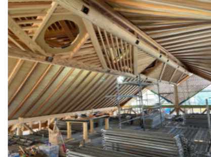
唐破風の垂木間に3次曲面の天井板が貼られる。龍骨は現場でさらに2間伸ばして15.4mになった。妻壁は格子組のガラス開口とし、朝夕は光が差し込む。
