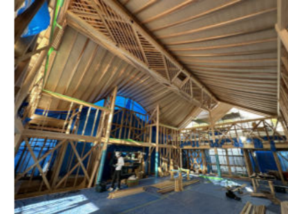
唐破風の垂木間に3次曲面の天井板が貼られる。龍骨は現場でさらに2間伸ばして15.4mになった。妻壁は格子組のガラス開口とし、朝夕は光が差し込む。
