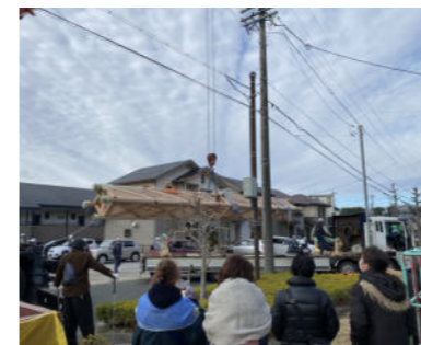
長さ12mの龍骨を大型トレーラーで搬入。クレーンで吊り上げて棟持柱の上に設置した。龍骨上げは檀家や近隣住民など多くの見物者が訪れた※4
