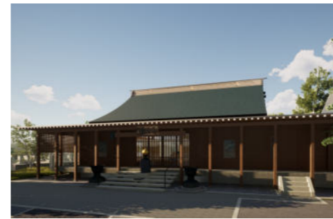
外観は銅板屋根を再利用して面影を残しつつ、バリアフリー動線となる天竜杉の回廊を加える
